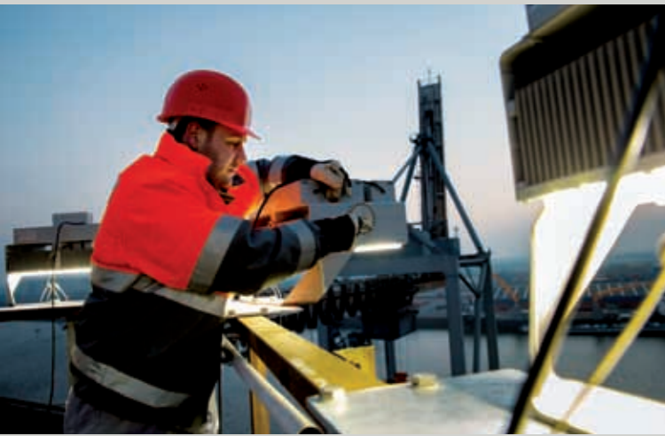
Manuel Cutivel beim Einbau von LED-Strahlern in luftiger Höhe.
