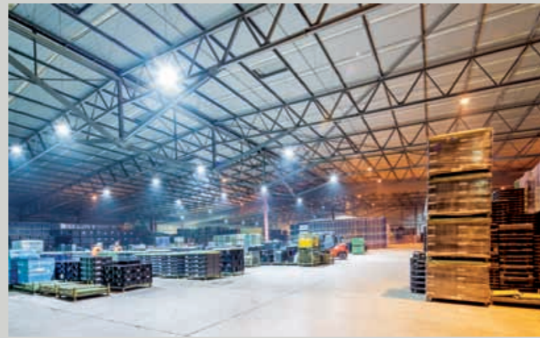
Im Schuppen 24 C hat sich durch den Einsatz von LED das Arbeitslicht deutlich verbessert.
